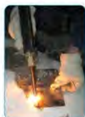
Сварка угольным электродом
